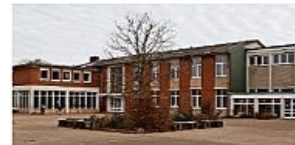
Die künftige Nutzung der seit 2016 geschlossenen Hesedorfer Grundschule wurde am Dienstag in der Aula diskutiert
